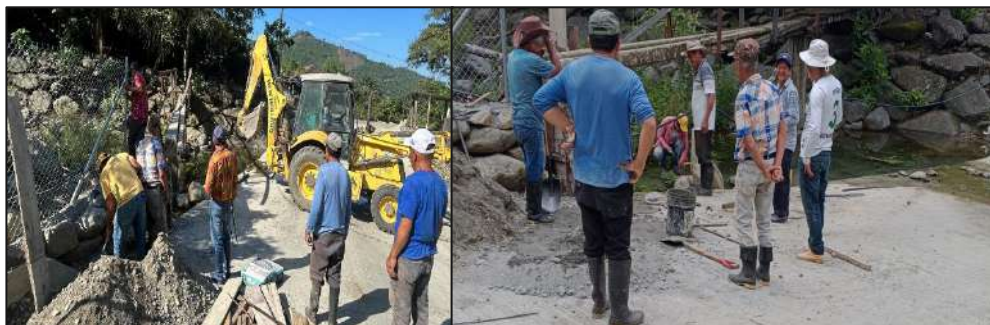
Imagen 09: Apoyo en los trabajos de construcción de un puente peatonal en la quebrada del barrio Almendro Norte
