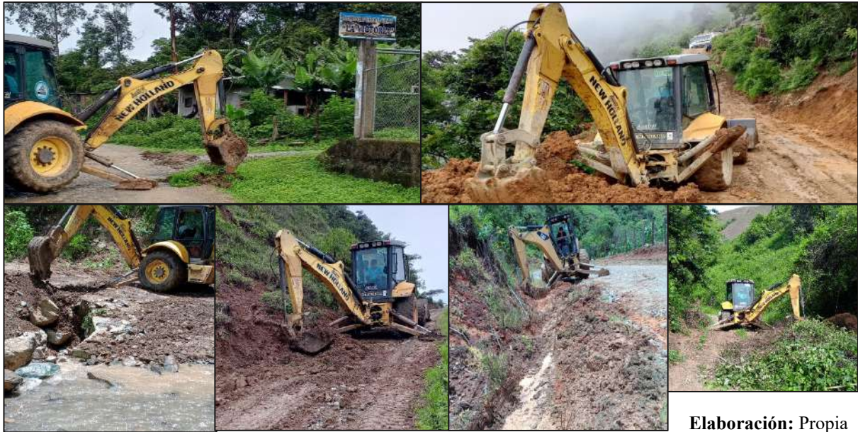
Imagen 05: Mantenimiento de la vialidad de la parroquia La Victoria
