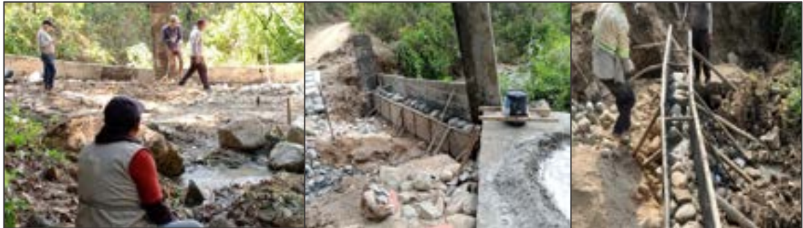
Imagen 08: Intervención en la quebrada del barrio Pitayo a través de la adecuación de un badén
