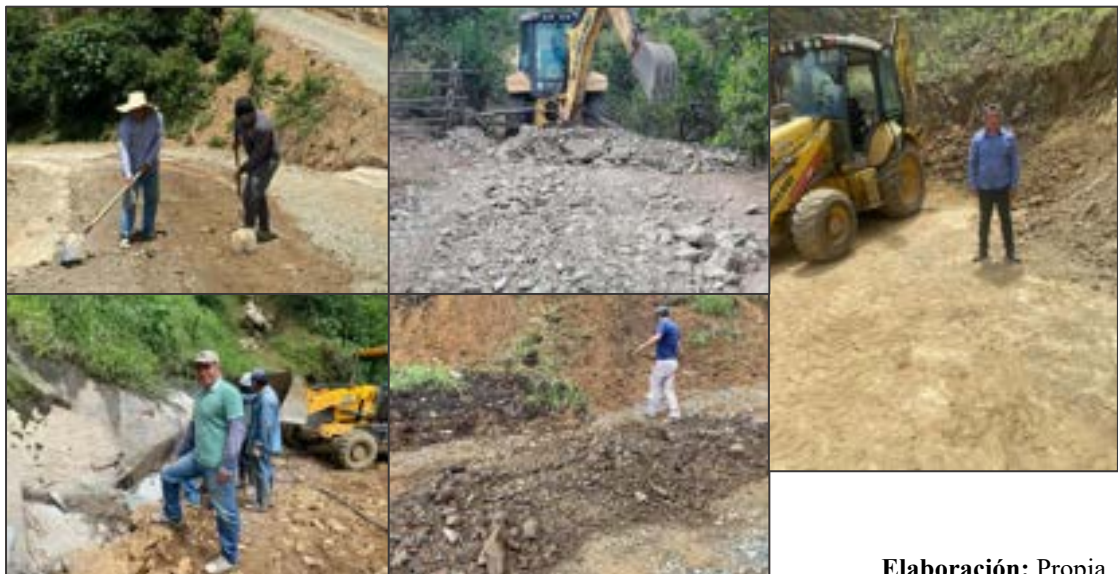
Imagen 06: Mantenimiento de la vialidad de la parroquia La Victoria
